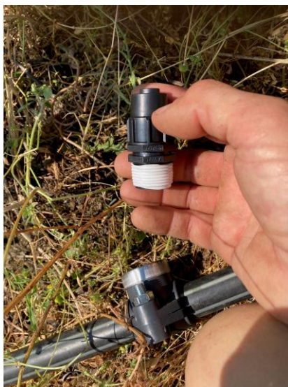
Visser le raccord écrou
